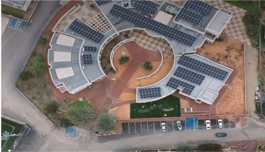
תרשים 41. מערכת סולארית על גג בית הספר יסודי ג' אלמוסתקבל (מימין) ועל גבי בניין המתנ"ס והספריה העירונית בכפר קרע. בשני הבניינים ההספק המותקן הוא בגודל 150kW
