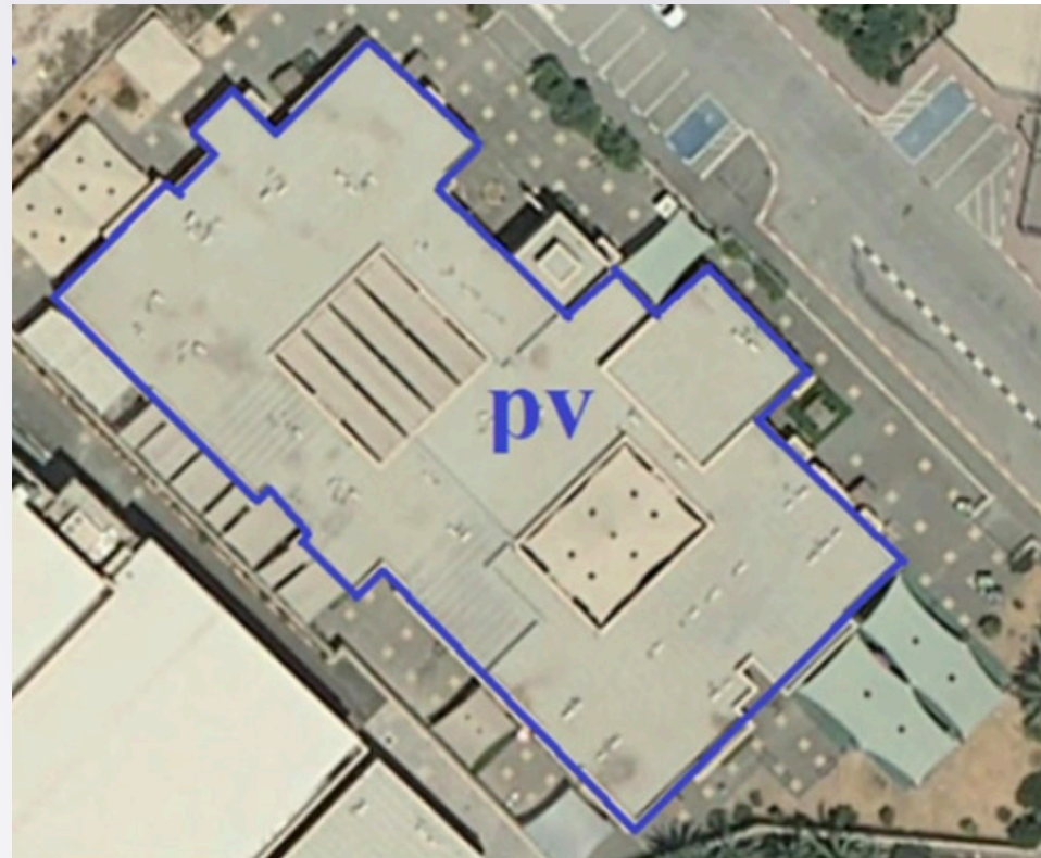
1. בי"ס אלכיאן לקשר ותקשורת אוטיזם (250kW)
