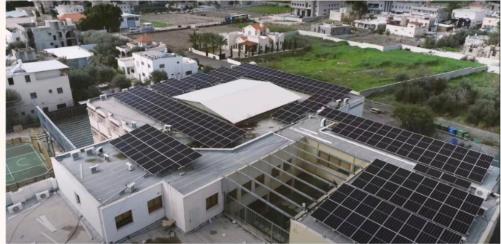
תרשים 41. מערכת סולארית על גג בית הספר יסודי ג' אלמוסתקבל (מימין) ועל גבי בניין המתנ"ס והספריה העירונית בכפר קרע. בשני הבניינים ההספק המותקן הוא בגודל 150kW
